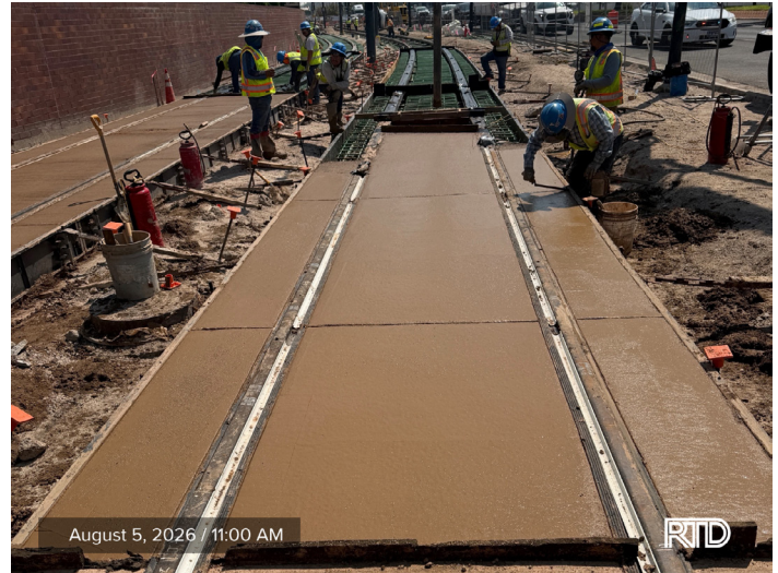
2 | Concrete Pour Colfax Avenue Alignment | August 5, 11:00 AM
